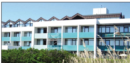
Die Ferienanlage Aquantis bei der Renovierung
