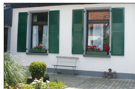
Instandsetzung im Stil eines „Bergischen Landhaus“ mit altgrünen Fensterläden.
