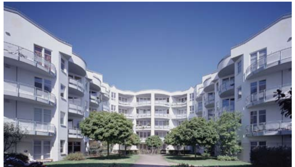
Die Sanierung des Wohnobjekts umfasste 12.000 m² Fassaden- und 2.500 m² Fensterfläche.
