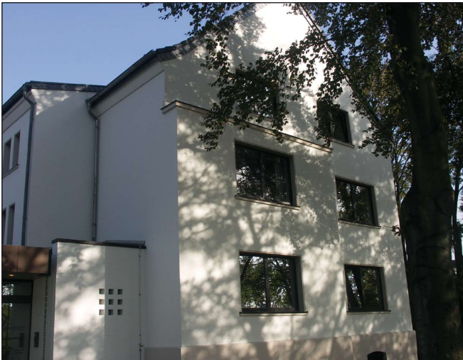
Mannesmann Betriebskrankenkasse in Düsseldorf
