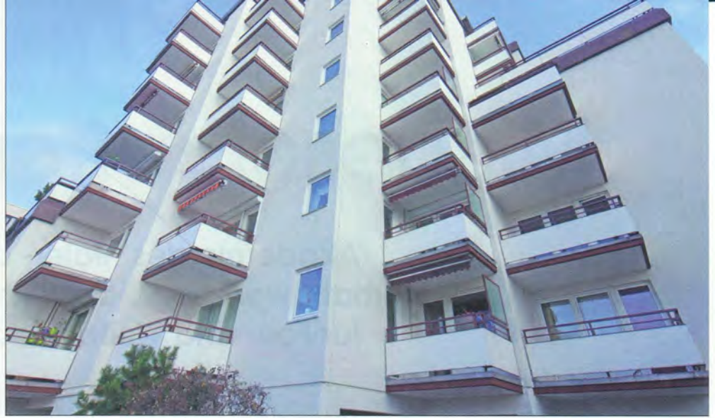
Wegen der vielen Terrassen und Balkone handelte es sich um ein besonders aufwendiges und umfangreiches Projekt. (Fotos: Herbol)
